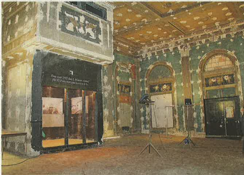
Das ehemalige Kino Razzia im Seefeld wird renoviert. SOM
